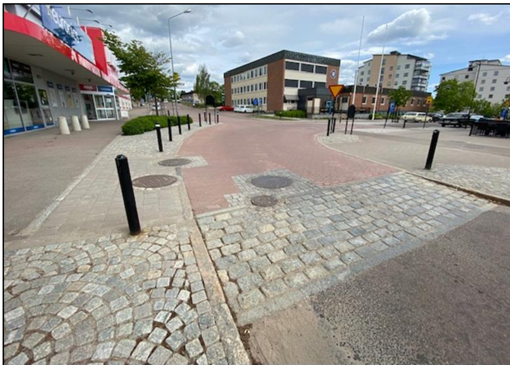
Exempel från Torsby kommun; olika markbeläggningar avgränsar olika funktioner, övergång från asfalt (gata) till ett gatutorg (passage) med mindre markplattor, kullersten samt svarta pollare.
