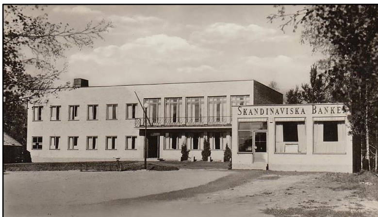
Historiskt foto; Hällefors kommunhus, i flygelbyggnaden inrymdes en banklokal
