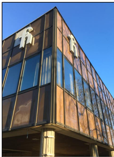
Folkets hus med upphöjt tak och räfflade betongpelare
