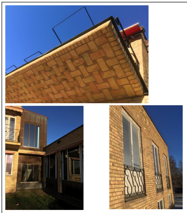
Detaljer Hällefors kommunhus; undersida av balkong med fasadtegel, smidesjärnsräcken, tillbyggnad mellan huvudbyggnad och flygel.
