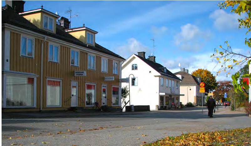
Schillingvägen, äldre byggnader med verksamheter, god skala och omhändertagna fasader ger ut ordnat uttryck för stadsrummet
