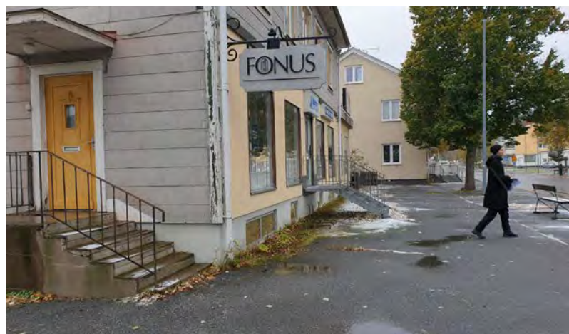
Östra delen av Sikforsvägen, bristande underhåll, nya tillägg i form av trappa och stora asfaltsytor
